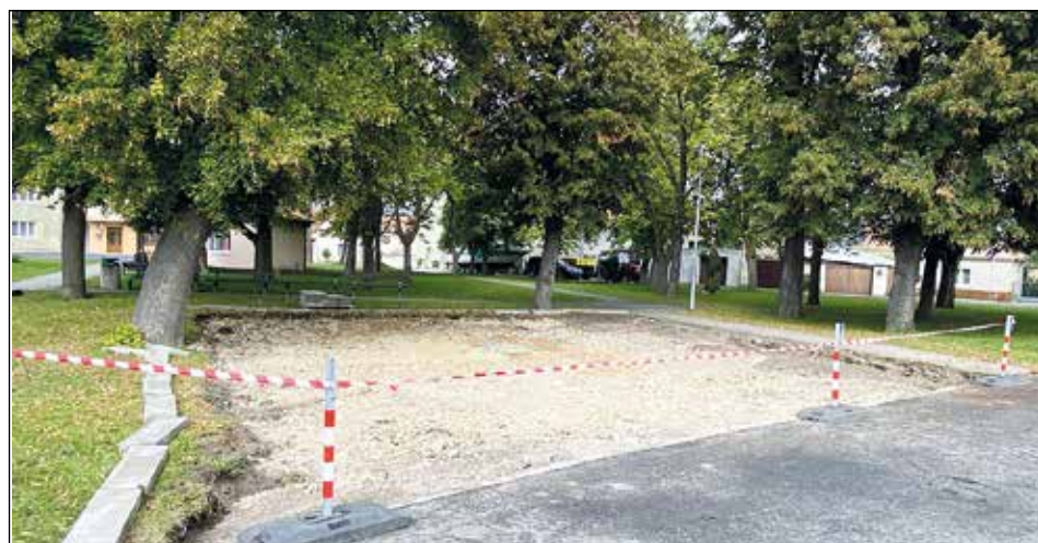
Aby se nám na příští pouti lépe tančilo, zajistila obec úpravu plochy na návsi v Chodounech. Práce začaly v polovině září.
